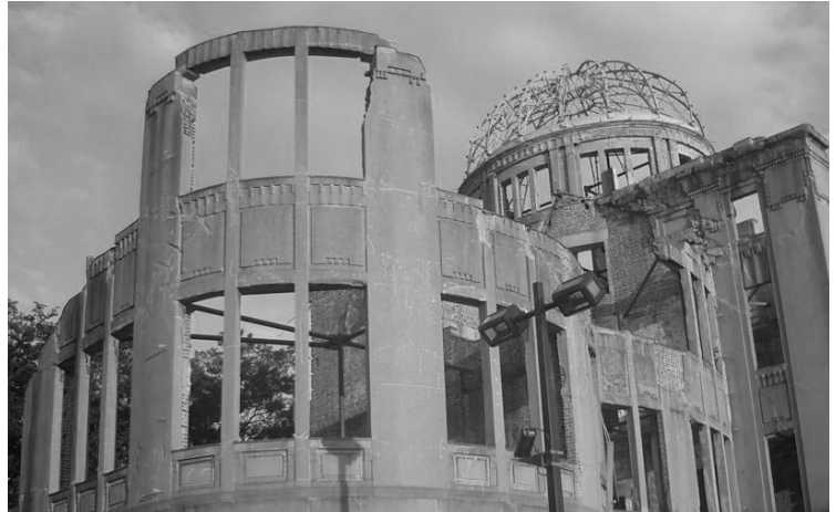
Edifício em Hiroshima cuja estrutura interna desabou.
