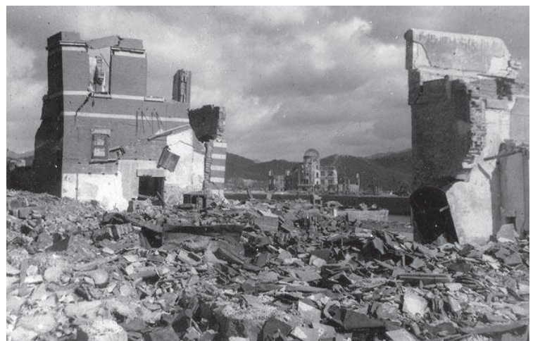
Edifícios de Hiroshima sem estrutura interna que perderam fachadas.
